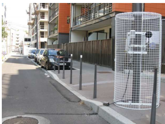
Humidification de chaussée routière
