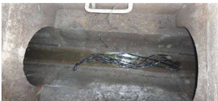
Octopus installé dans un regard
