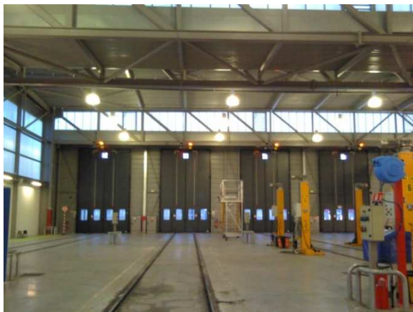
Chemin de câble 750V
