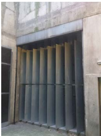
Exemple rideau métallique Puits JEAN GILLES
