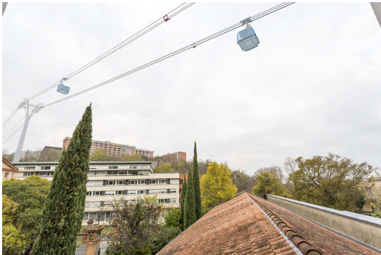
Pylône P4 vu depuis le Lycée Bellevue
