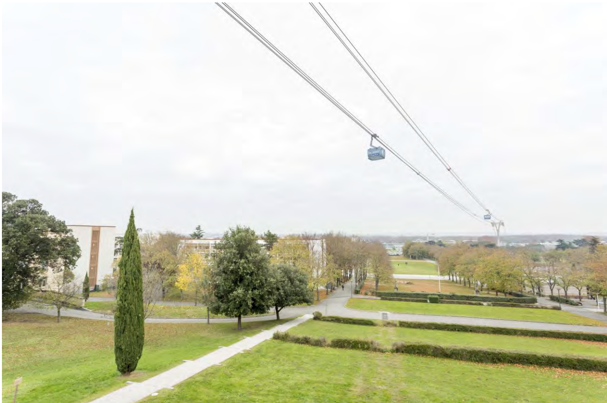
Pylône P5 vu depuis le Lycée Bellevue
