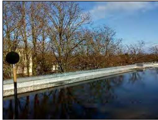
Photo depuis le point de mesure
