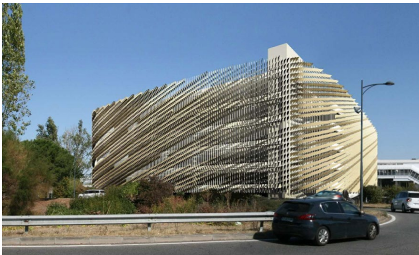
Figure 9, Façades Est (face métro) et Ouest (face giratoire) du P+R
