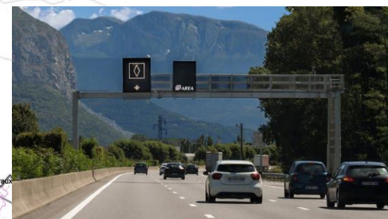
Exemple de VOM sur l'A48 à Grenoble.
