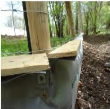
Fixation du bavolet de barrière type anti-intrusion d'amphibien
