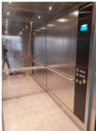
Pose d'un miroir
