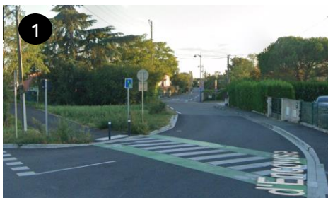
1 D64 Chemin Virebent : voie verte avec franchissement de route marqué et dissocié du passage piéton
