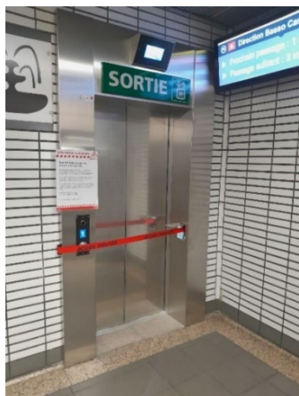
Elargissement de la porte
